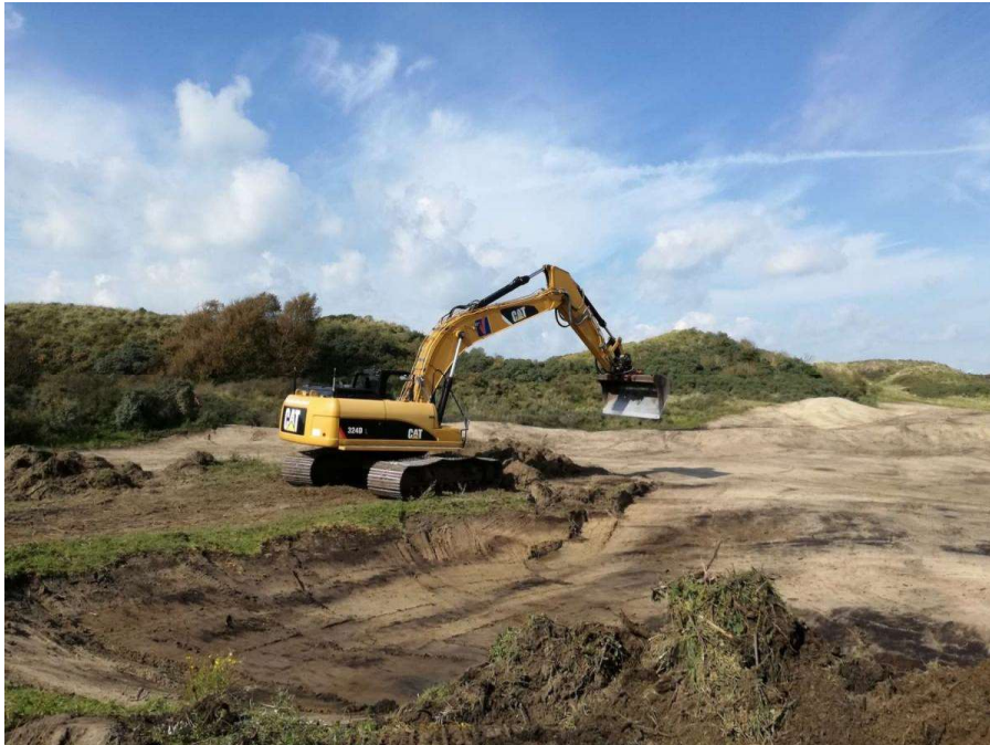
Plaggen met een hydraulische kraan en platte bak (foto: Vermaire Breezand)
